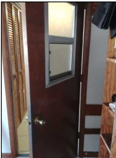
Hollow wood door at garage/kitchen
